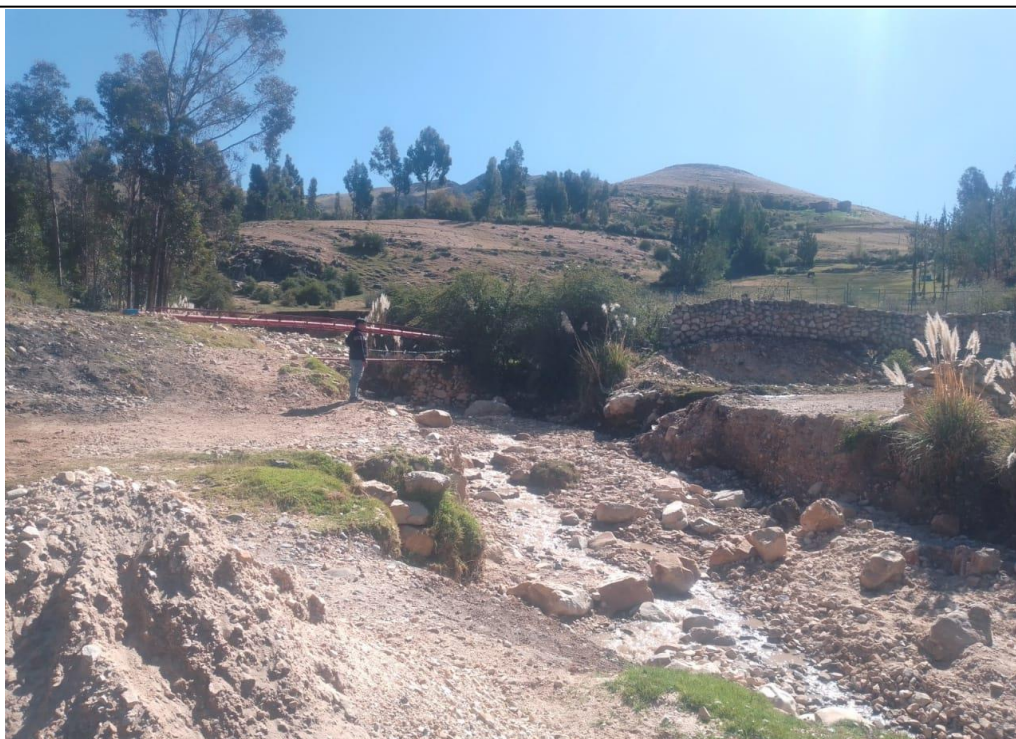
FIGURA N°02: PLATAFORMA DE LA VIA COLAPSADA Y PUENTE ARRAZADA POR UNA CRECIDA DE LA QUEBRADA TUNYO EN LA EPOCA DE LAS LLUVIAS Y EXISTE PASE AEREA XTUBERIA DE AGUA PARA RIEGO
