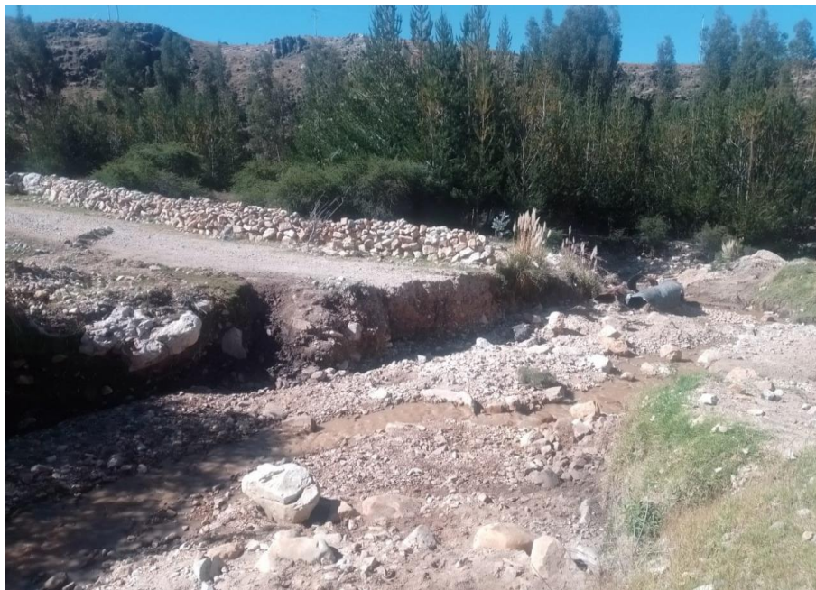
FIGURA N° 03: ALCANTARILLA ARRAZADA DENTRO DEL CAUCE DE LA QUEBRADA TUNYO, CON SOCAVAMIENTO Y ARRASADO CON MATERIALES EN SU PASO.
